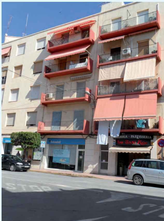
Viviendas construidas por la Caja de Novelda, segundas instalaciones, hoy del BS, y a la derecha donde estuvo el almacén agrícola.
